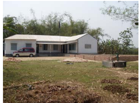
Bild 4: Die drei fertigen Klassenzimmer und ein Lehrerzimmer (März 2009) Picture 4: The three almost complete class rooms and one teacher's room (March 2009)
