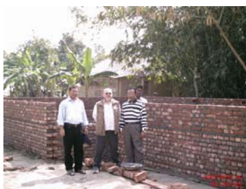
Bild 3: Die Grundmauern der Schule wachsen
